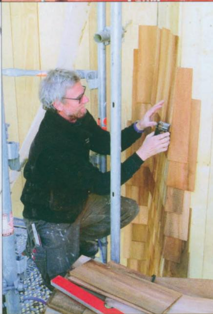
**Draussen hört man fast nur das rhythmische und regelmässige «Tack» der Druckluft-Nagelpistole. Gut -, ab und zu auch mal eine lebhafte Unterhaltung der Holzbauer. Sie sind dabei, die Fassade mit Schindeln einzukleiden.**
